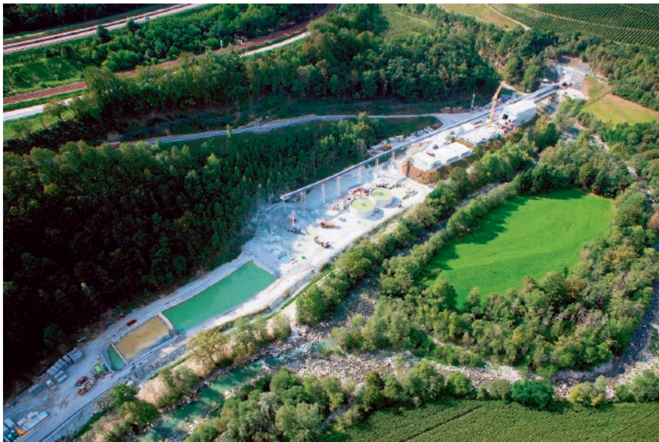
Рис. 6. Строительство базисного тоннеля Бреннер
