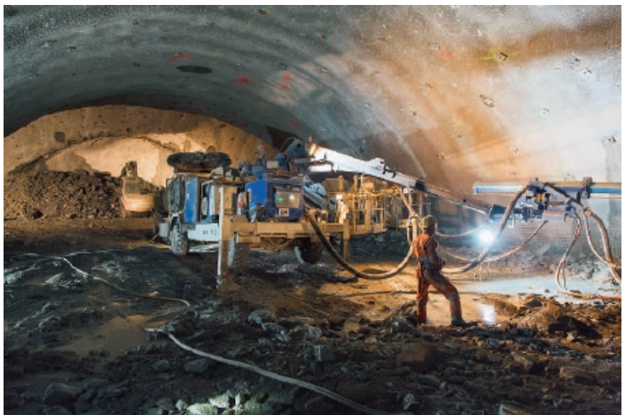
Рис. 5. Строительство базисного тоннеля Земмеринг
