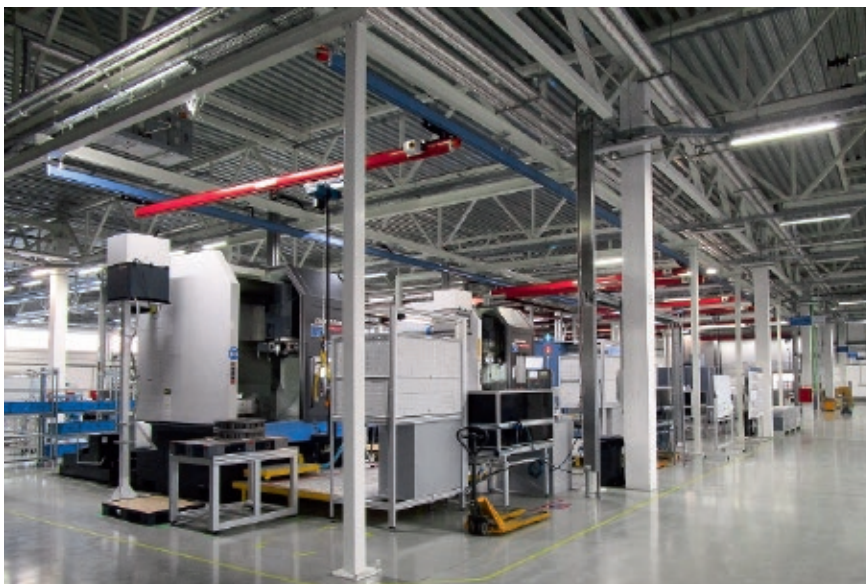
Производственный корпус завода «Кнорр-Бремзе 1520» в Петербурге
