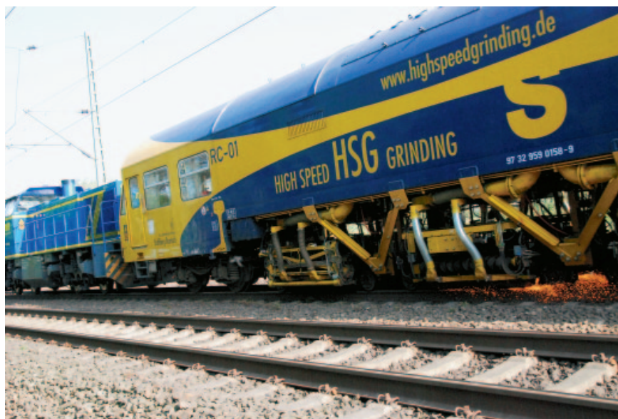
Рис. 2. Рельсошлифовальная машина RC-01 в работе
