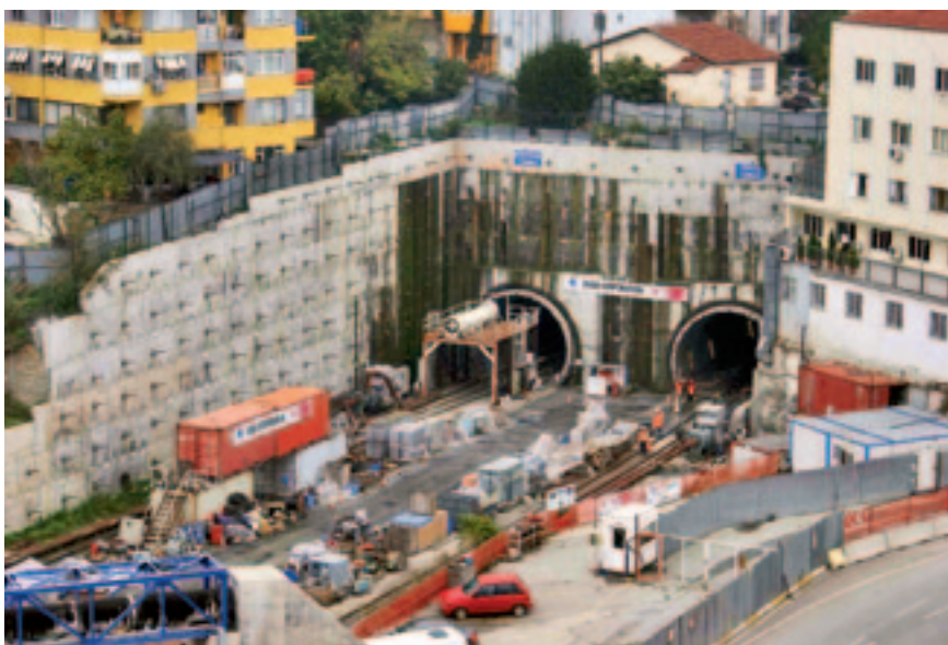
Рис. 4. Строительная площадка у портала тоннеля в центре Стамбула
