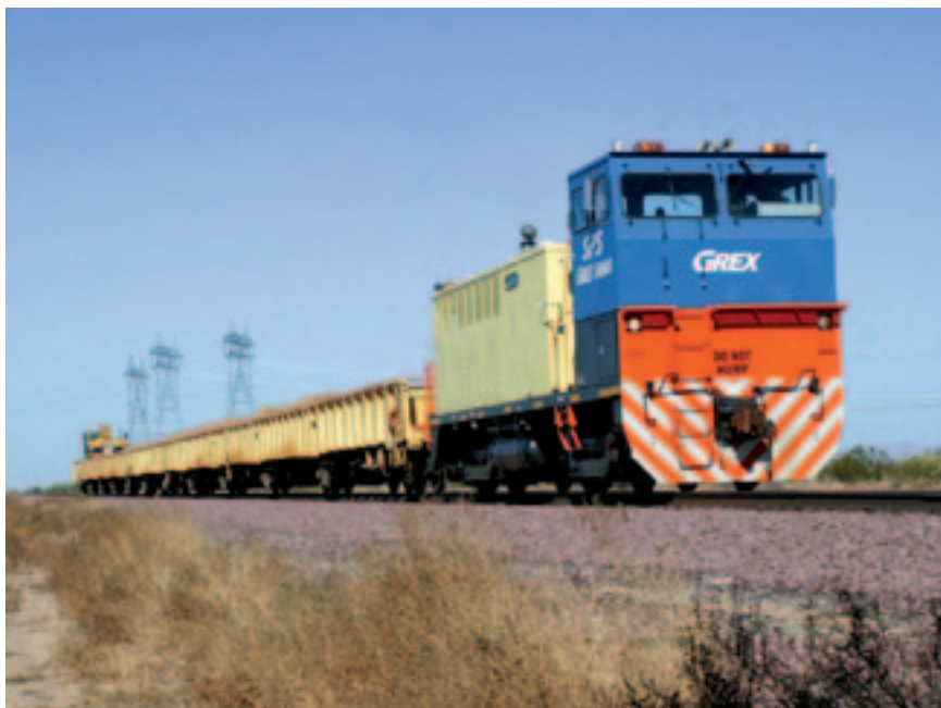
Рис. 9. Поезд типа Self-Powered Slot компании Georgetown Rail Equipment
