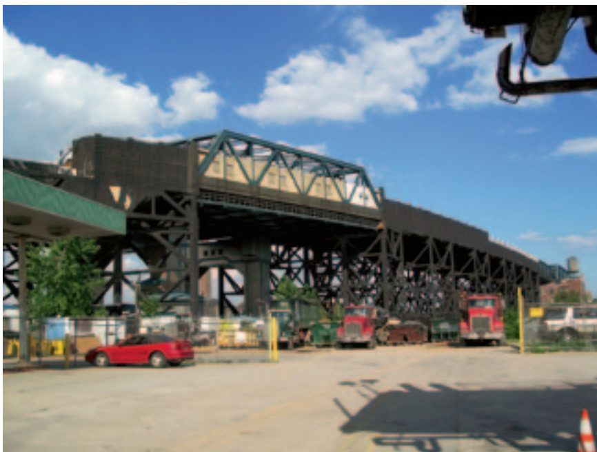
Рис. 6. Начало работ по реконструкции путепровода Калвер
