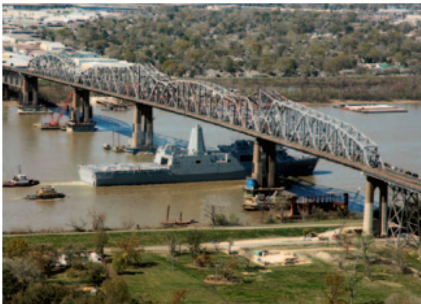
Рис. 2. Мост Long Bridge через р. Миссисипи
