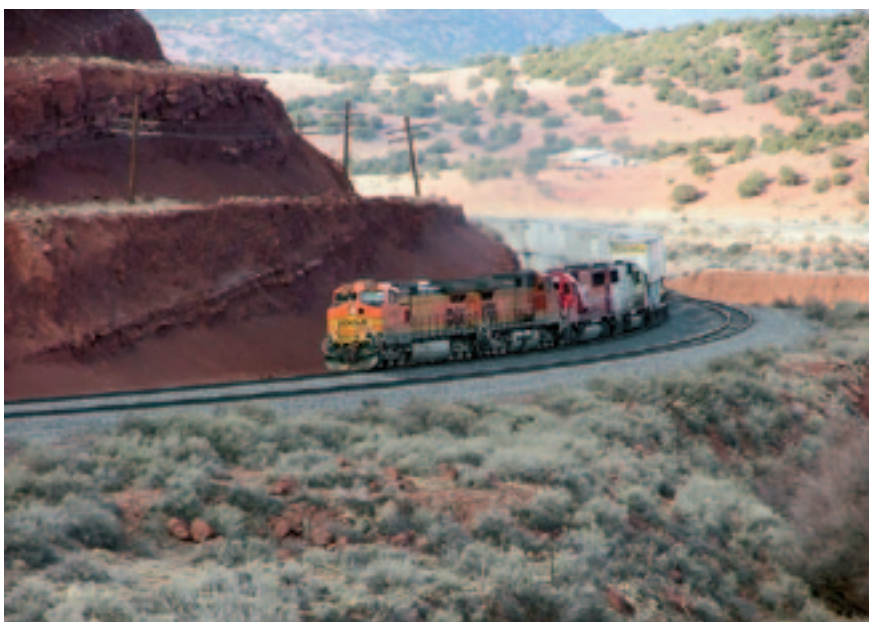
Рис. 1. Участок линии Abo Canyon с уложенным вторым путем
