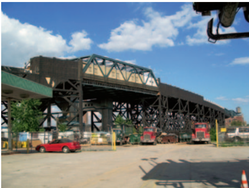
Рис. 6. Начало работ по реконструкции путепровода Калвер
