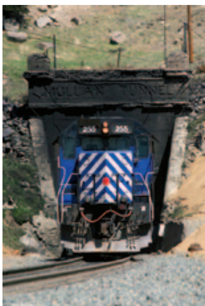
Рис. 3. Портал тоннеля Маллен
