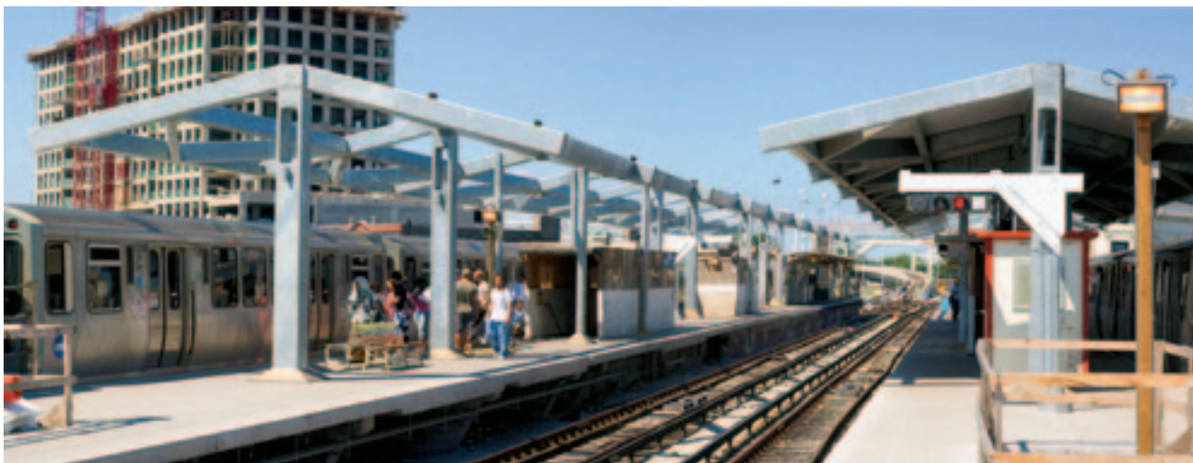
Рис. 4. Станция Хауорд метрополитена Чикаго в ходе реконструкции
