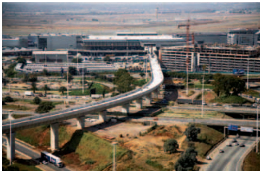
Рис. 5. Строительство станции Аэропорт и эстакады на подходе к ней
