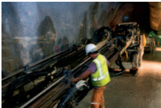
Рис. 2. Работы по проходке тоннеля (фото: Bombardier)
