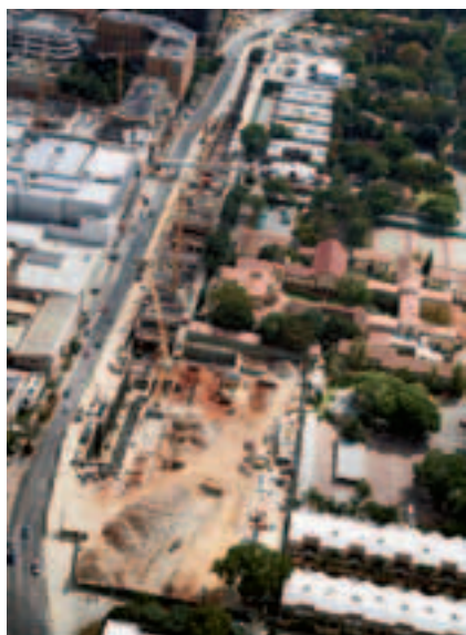
Рис. 4. Строительство подземной станции Роузбэнк
