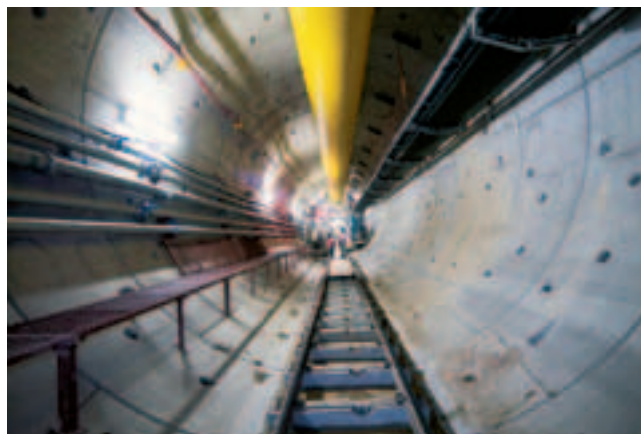
Рис. 3. Один из участков готового тоннеля
