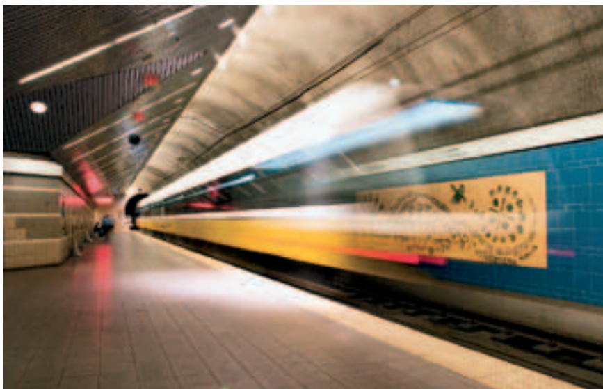
Рис. 1. Подземная пересадочная станция Ситиплейс сети DART
