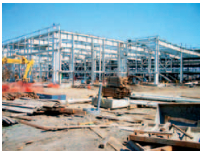
Рис. 6. Строительство депо Метро-Ист
