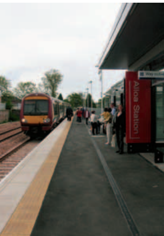
Рис. 2. Новая станция Аллоа
