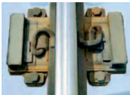
Рис. 2. Скрепление типа Loadmaster компании ATP
