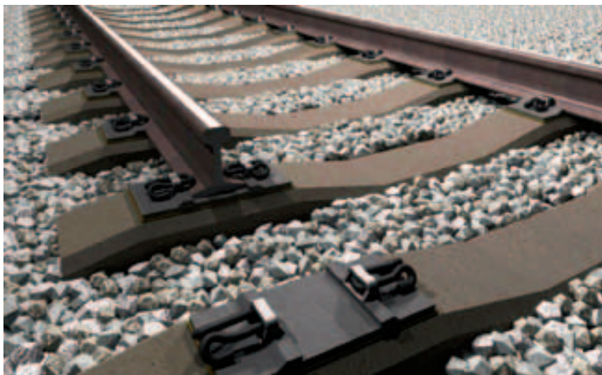
Рис. 3. Крепления корпорации NorFast для железобетонных шпал
