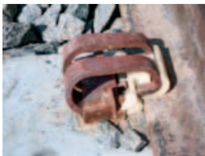
Рис. 1. Скрепление типа TCS корпорации AirBoss
