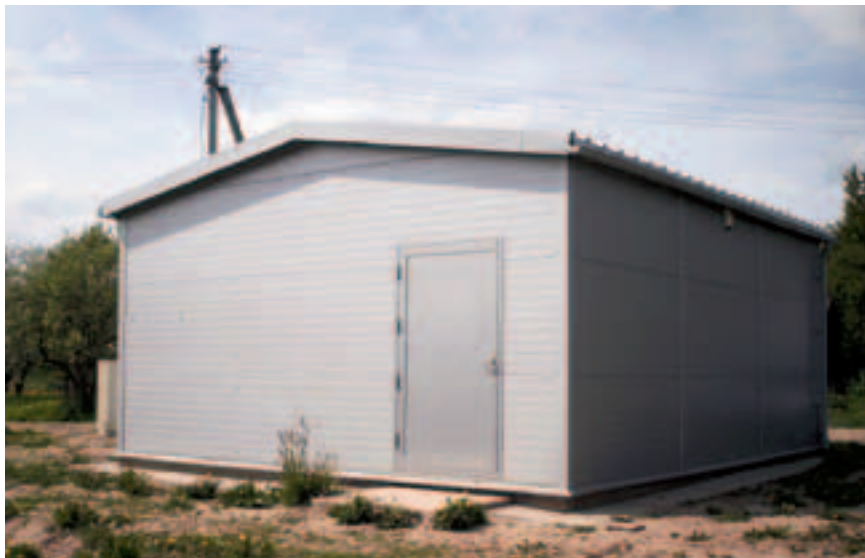
Рис. 6. Контейнер для размещения оборудования МПЦ
