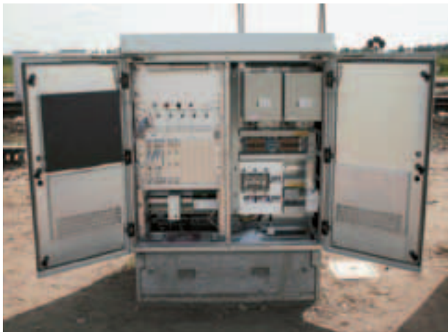
Рис. 9. Переездное оборудование Simis LC
