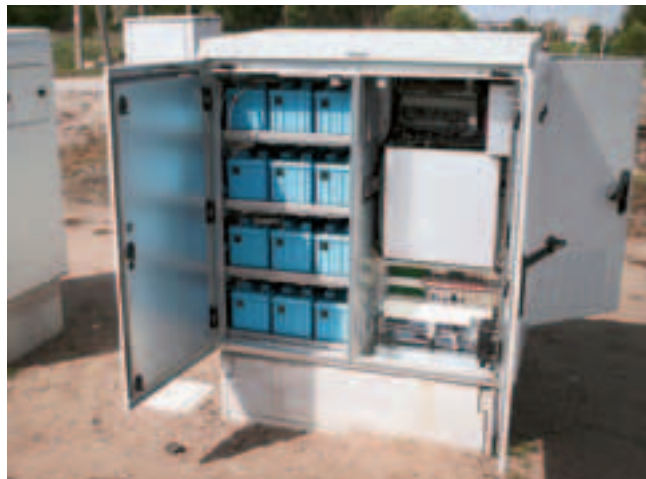
Рис. 9. Переездное оборудование Simis LC
