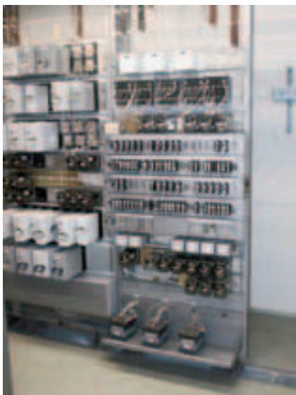
Рис. 8. Поставая аппаратура тональных рельсовых цепей
