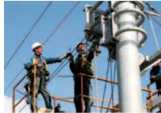
Рис. 1. Крепежные элементы в верхней части опоры
