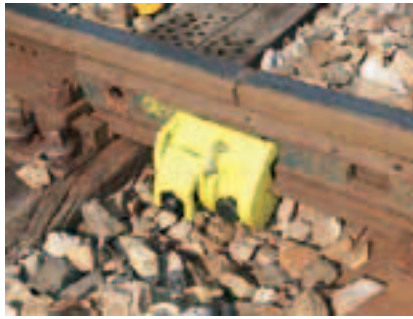
Рис. 5. Стяжное устройство типа Robel
