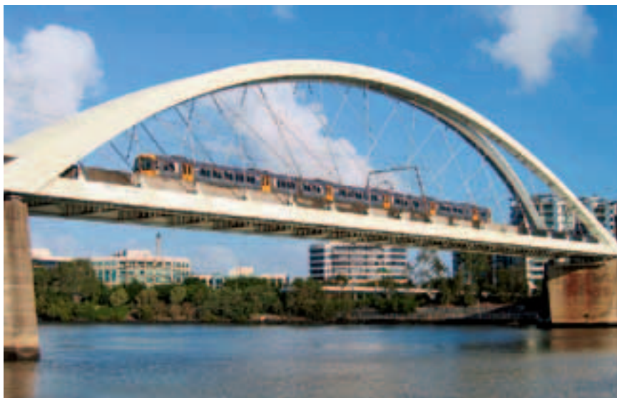
Рис. 4. Железнодорожный мост Меривейл в Брисбене
