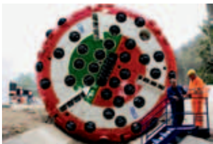
Рис. 2. Подготовка щита к проходке разведочной штольни
