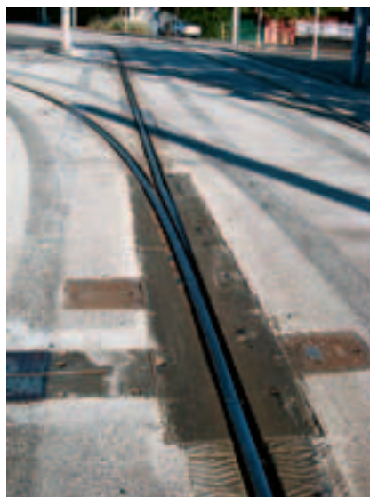
Рис. 2. Направляющий рельс транспортной системы в Кане
