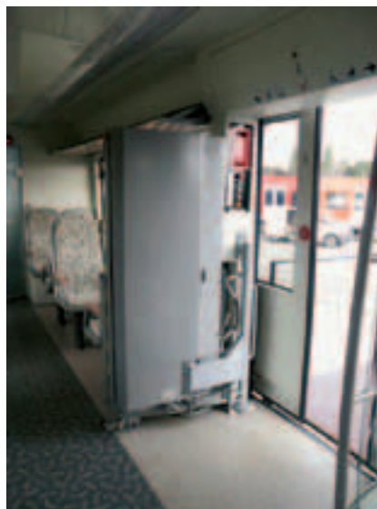
Рис. 7. Зона дверного проема
