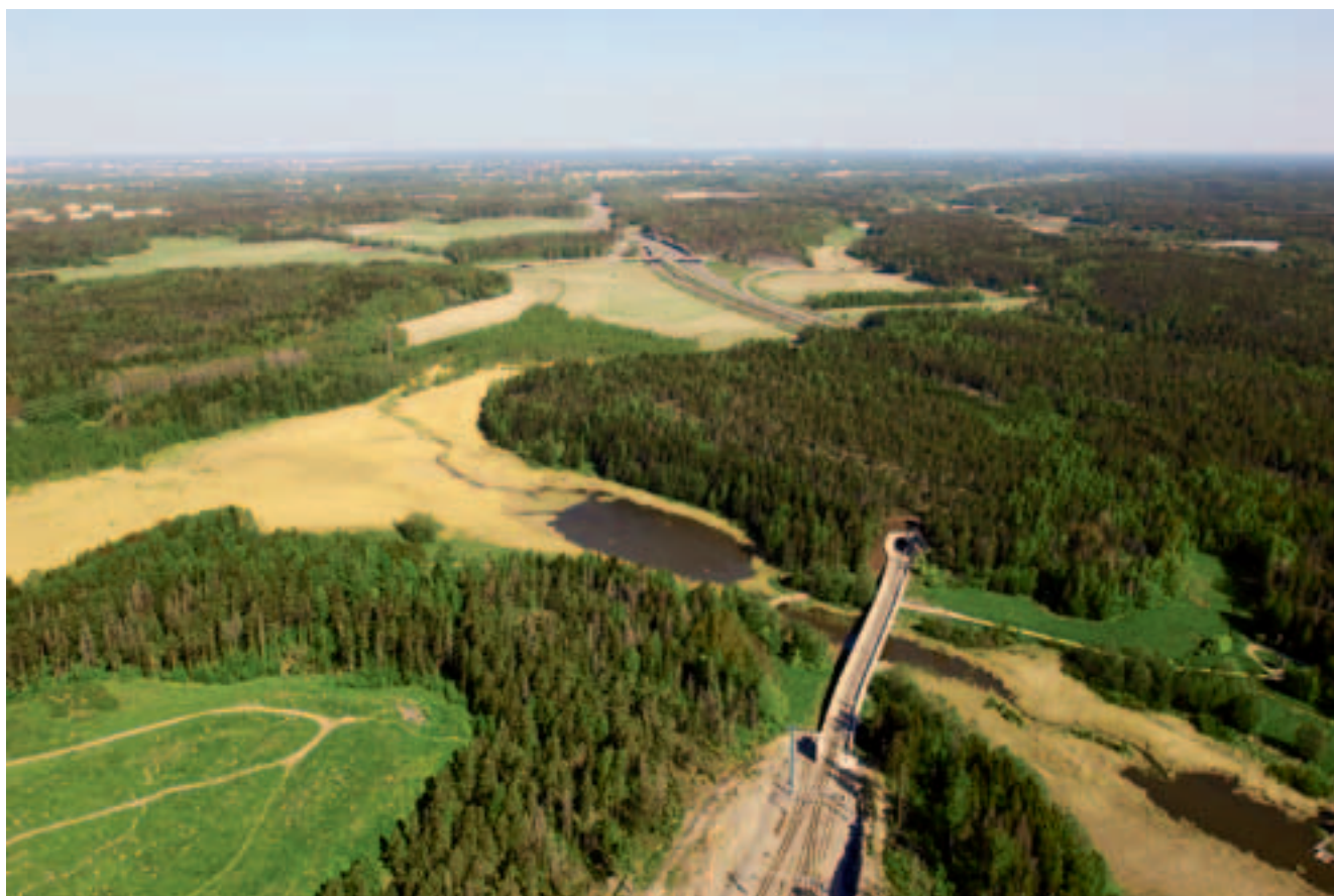
Рис. 3. Строительство линии у южного портала тоннеля Савио
