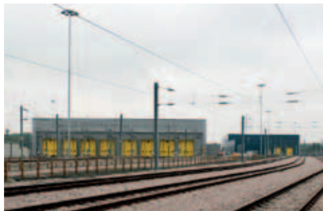
Рис. 3. Общий вид технического центра Темпл-Миллз (слева — основной производственный корпус)
