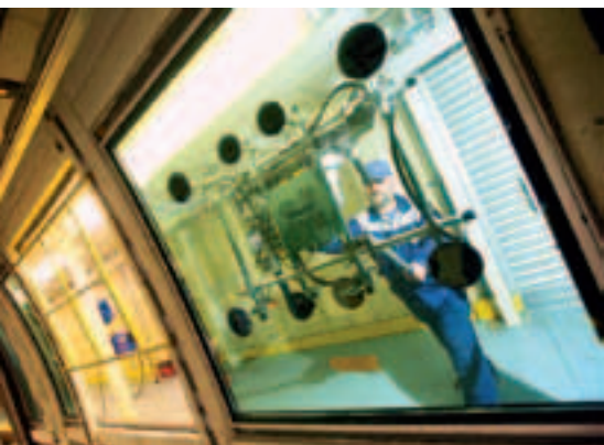
Рис. 7. Установка остекления в боковой стенке кузова (фото: Bombardier)
