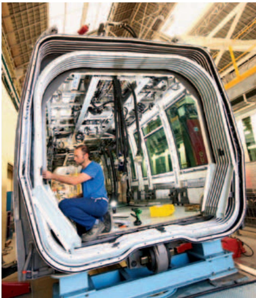
Рис. 8. Монтаж межвагонного прохода (фото: Bombardier)
