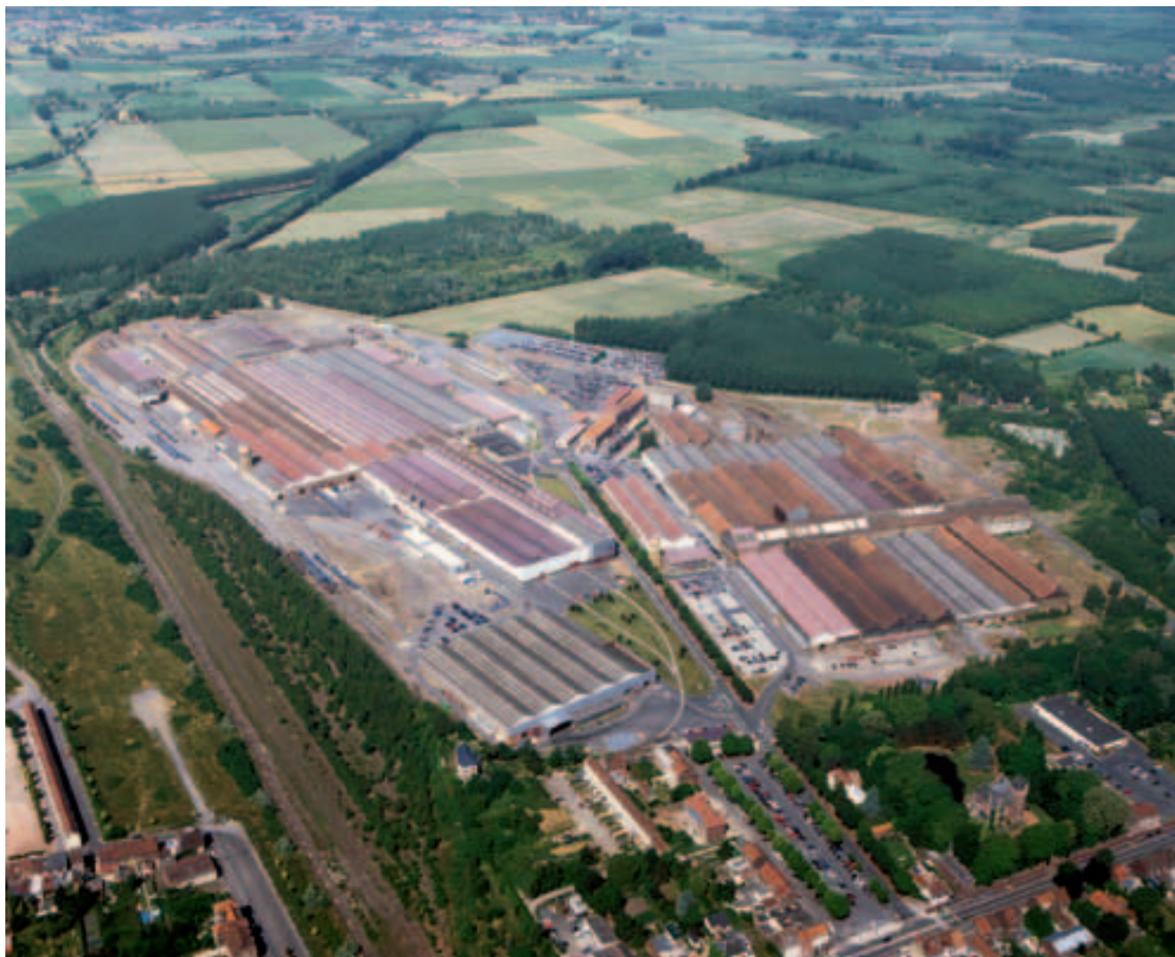
Рис. 9. Общий вид завода Bombardier Transportation в Креспене (фото: Bombardier)
