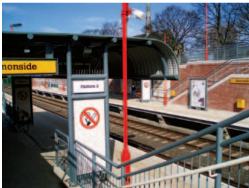
Рис. 3. Станция Саймонсайд системы Tyne & Wear Metro
