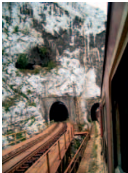
Рис. 1. Тоннель на магистральной линии София — Мездра
