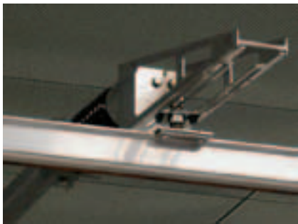
Рис. 2. Узел крепления контактной шины
