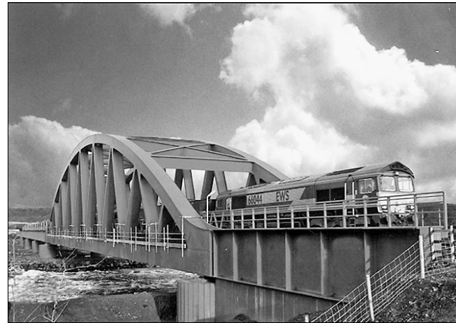
Рис. 5. Общий вид нового моста Upper Portrack
