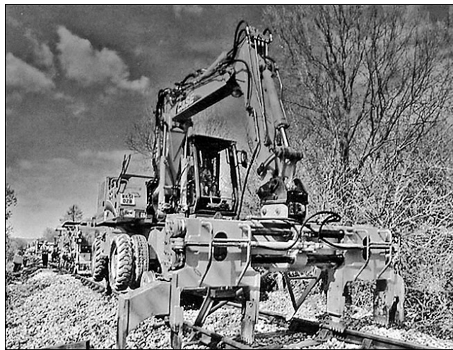
Рис. 1. Машинный комплекс для одиночной смены шпал в работе
