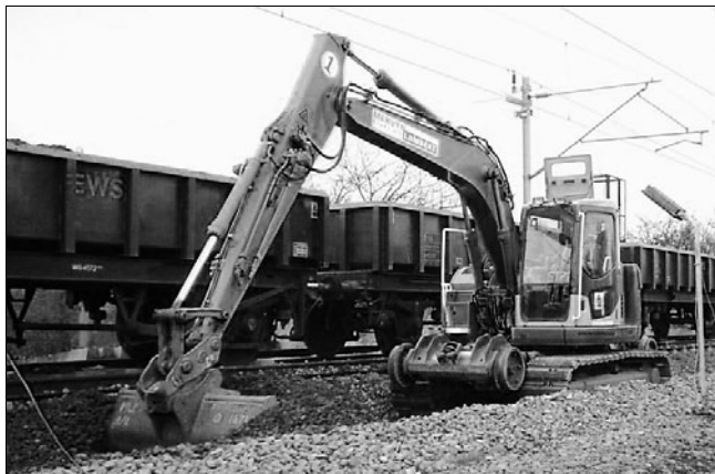
Рис. 1. Машина на базе гусеничного экскаватора типа PC128US
