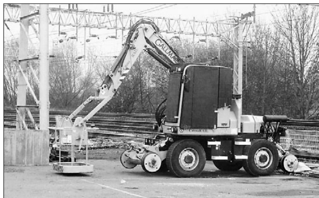
Рис. 2. Машина на базе экскаватора типа Gallmac RMW115
