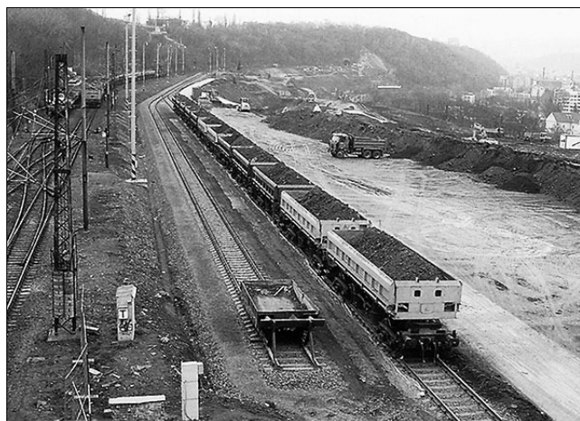
Рис. 7. Площадка для складирования и погрузки грунта в железнодорожные полувагоны
