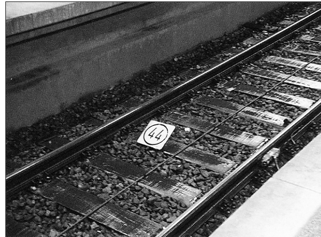
Рис. 1. Сигнальный знак АЛСН на пути у пассажирской платформы
