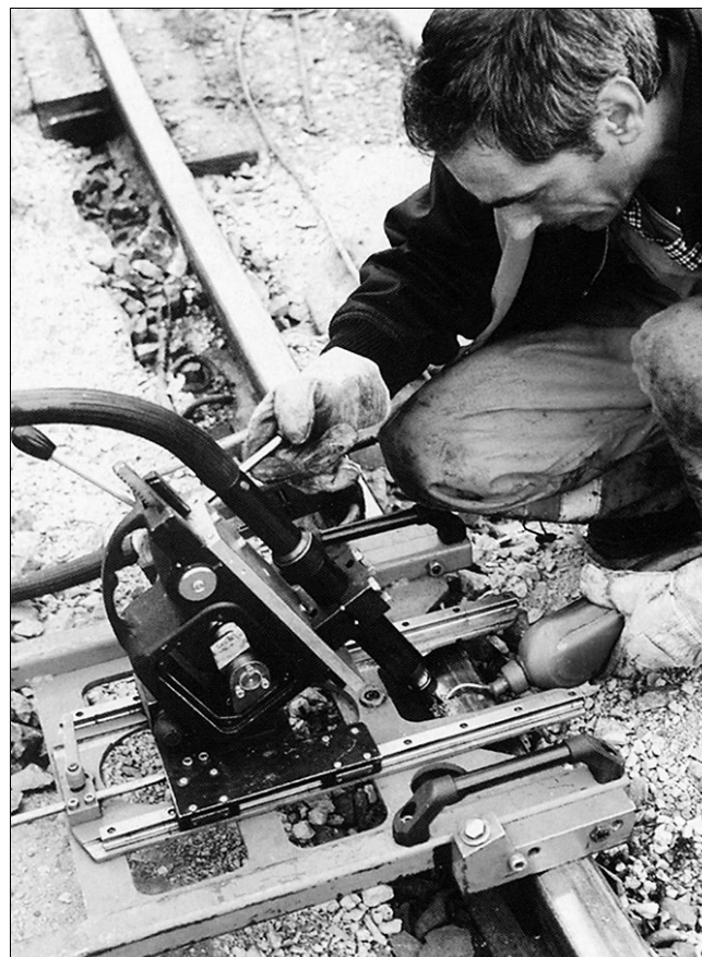
Рис. 1. Сверление отверстий в рельсе для установки лубрикатора
