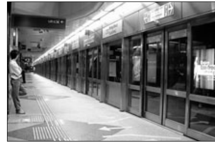
Рис. 5. Платформенные двери на одной из станций метрополитена Сингапура
