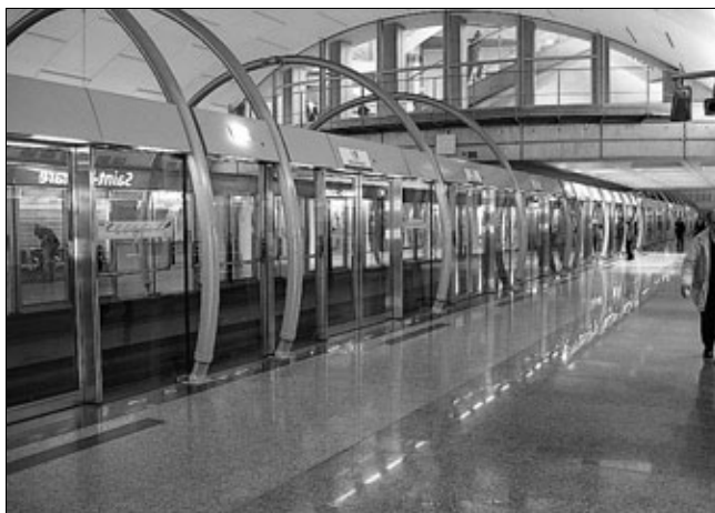
Рис. 1. Платформенные двери на одной из станций метрополитена Парижа
