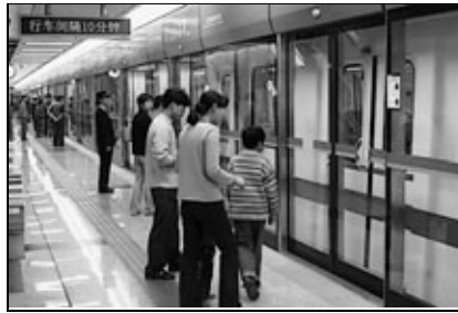
Рис. 4. Платформенные двери на одной из станций метрополитена Гуанчжоу
