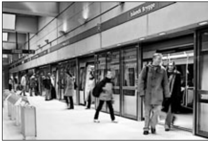
Рис. 3. Платформенные двери на одной из станций метрополитена Копенгагена
