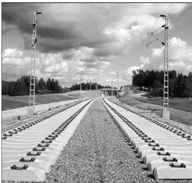
Рис. 1. Укладка пути на строящейся линии Керава — Лаhti
