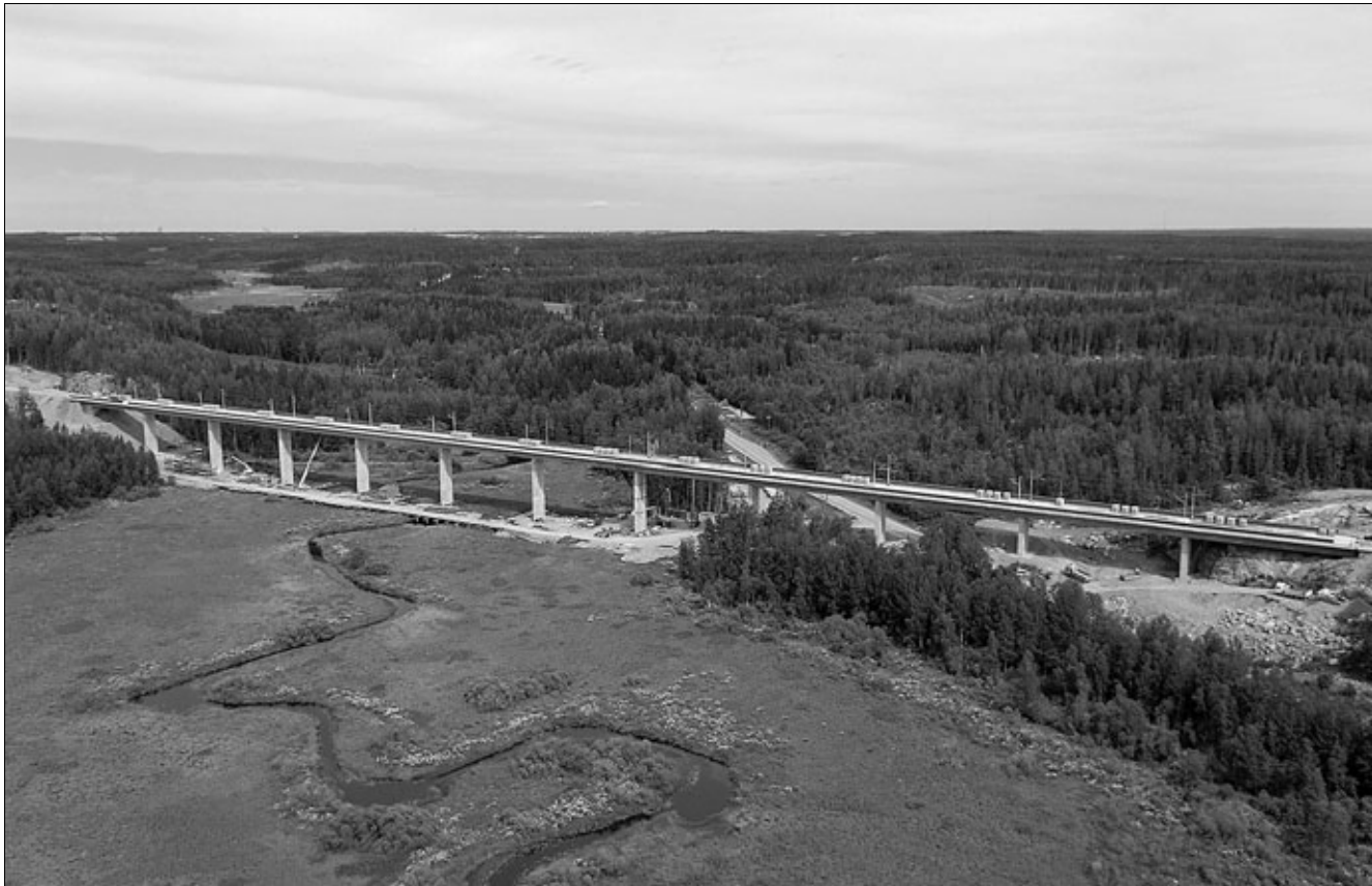
Рис. 2. Путепровод в районе г. Лухданмяки на линии Керава — Лахти
