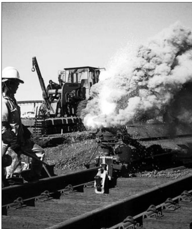
Рис. 2. Термитная сварка рельсов с применением оснастки компании Railtech Boutet
