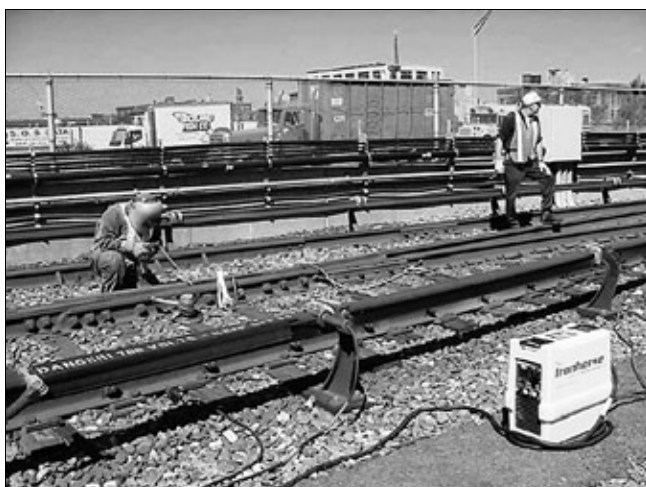
Рис. 1. Электросварка рельсов с применением оснастки компании ARCON
