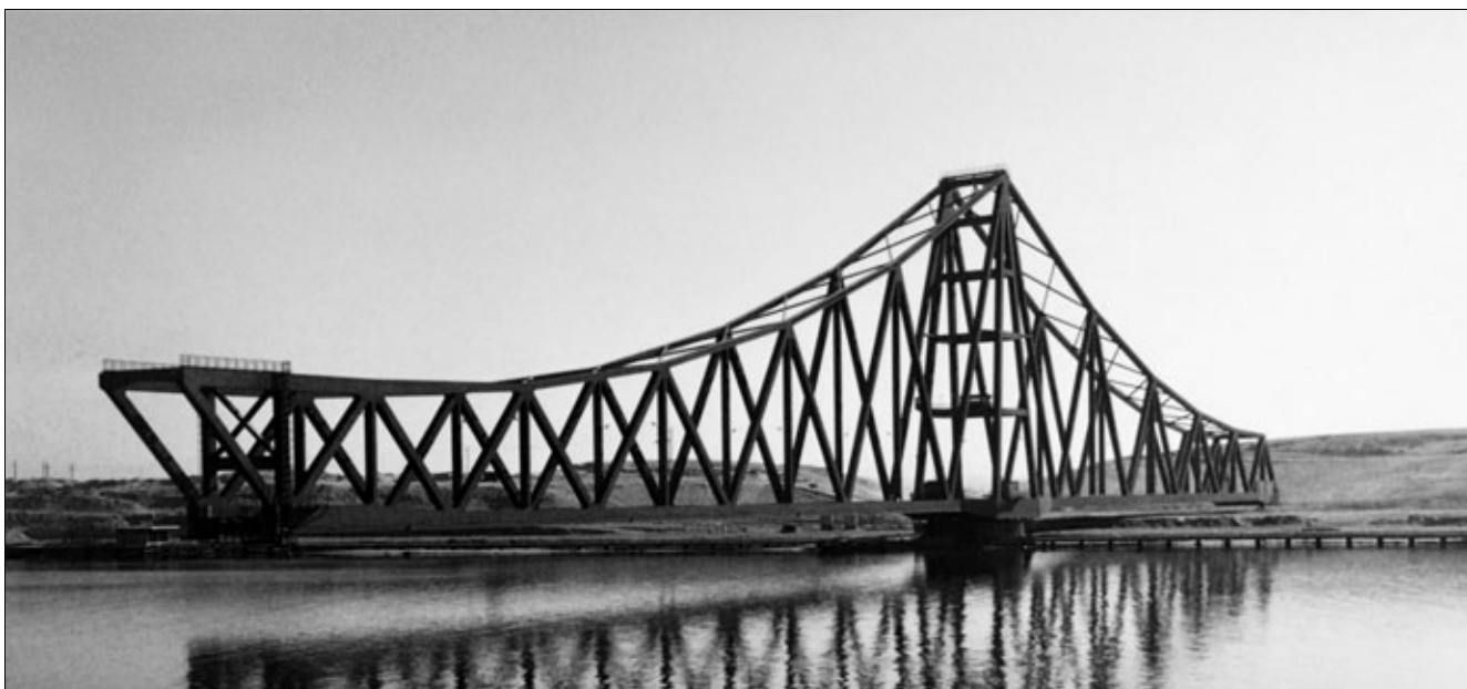
Рис. 8. Разводной железнодорожный мост через Суэцкий канал вблизи Фердана (Египет)
