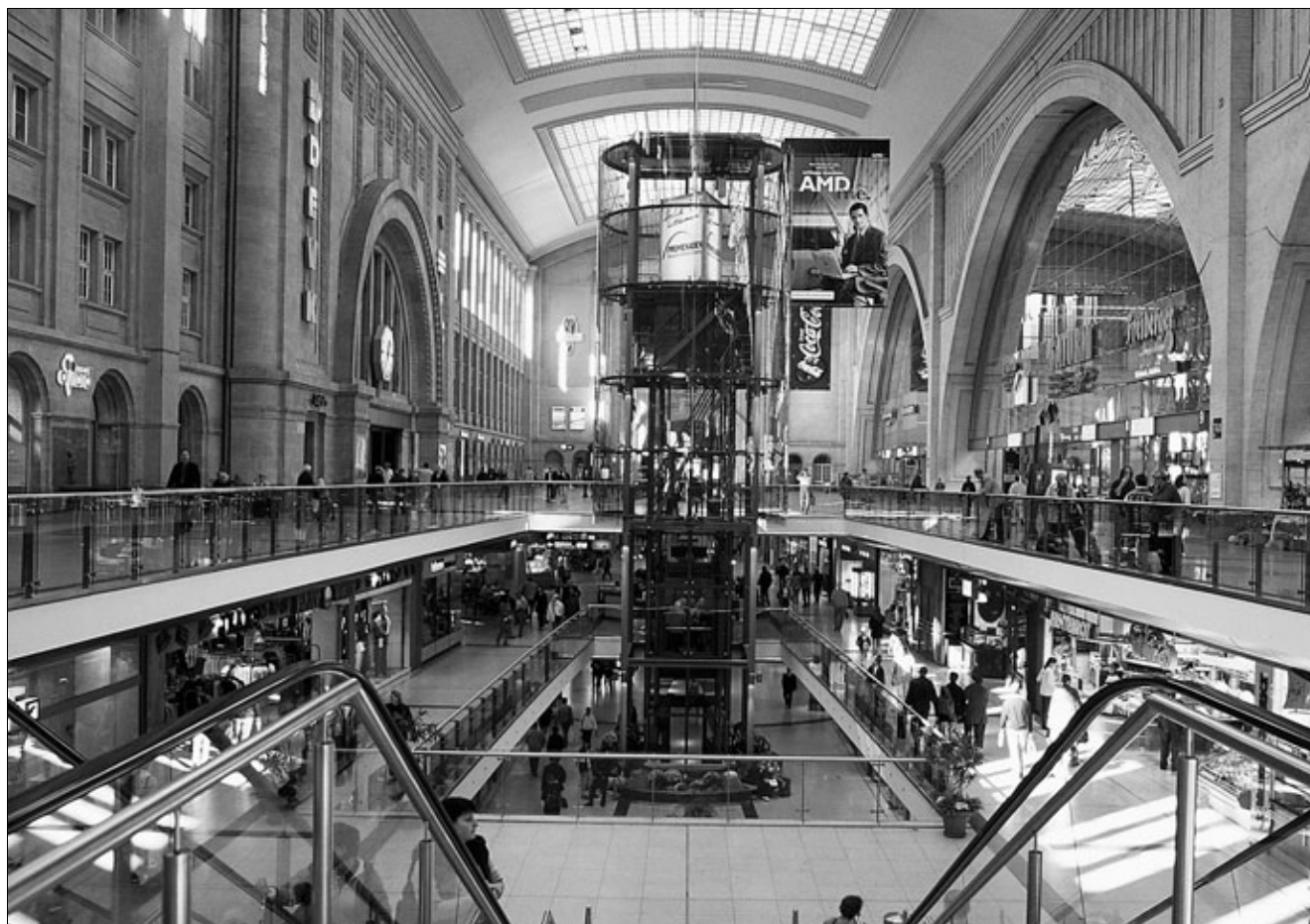
Рис. 3. Распределительная галерея и торговый комплекс на вокзале Лейпциг-Главный (фото DBAG, Кларнер)
