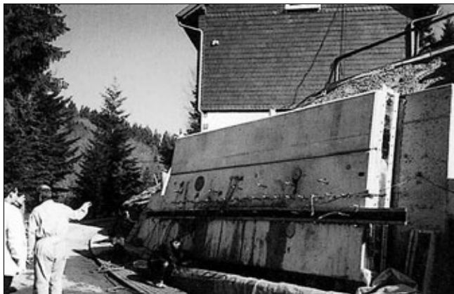
Рис. 3. Испытательная площадка для опробования инъекционной системы
