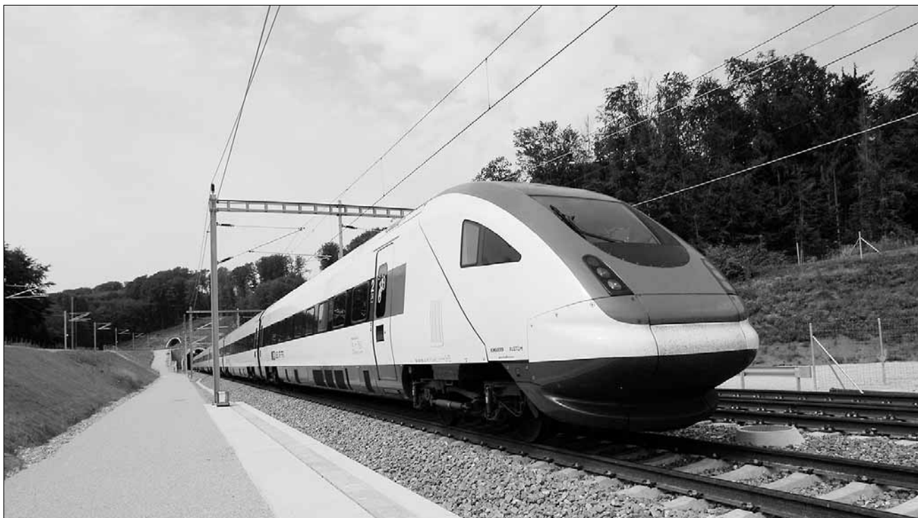
Рис. 2. Электропоезд ICN на линии Маттштеттен — Ротрист
