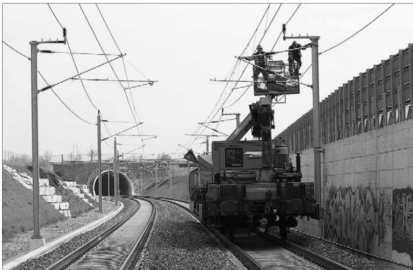
Рис. 3. Монтаж консолей контактной сети
