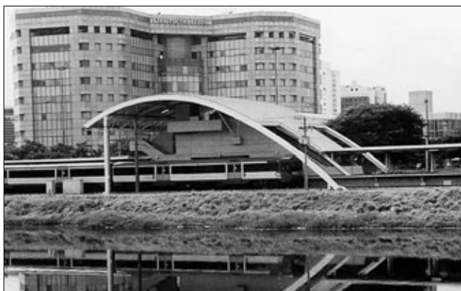
Рис. 5. Станция линии С компании СРТМ после модернизации
