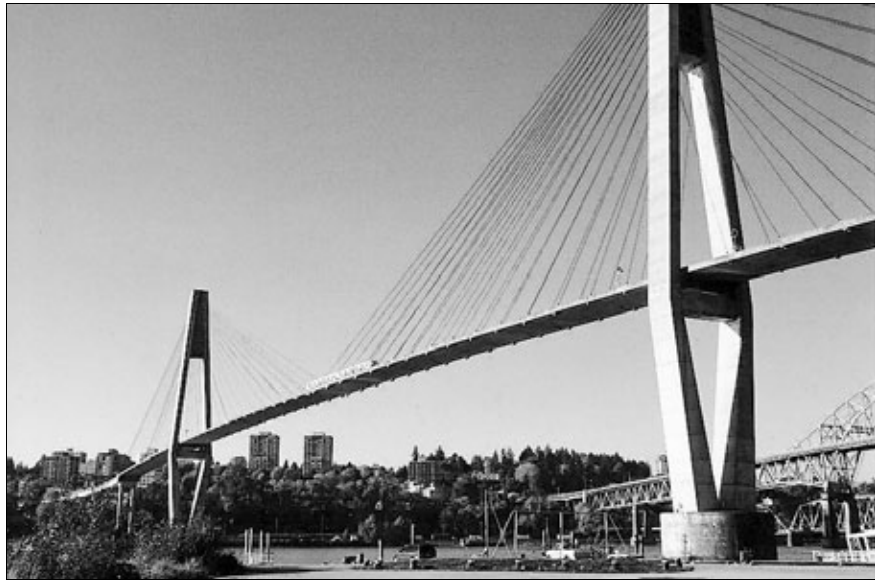
Рис. 13. Мост системы SkyTrain
