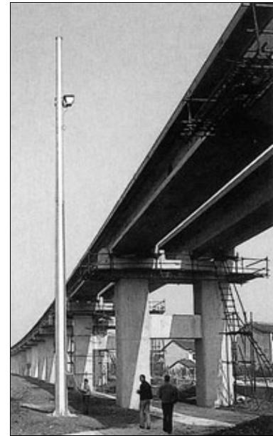
Рис. 4. Мачта с антенной базовой станции
