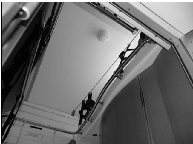
Рис. 2. Датчик дыма на потолке купе вагона WLAB 173.1 (фото: DBAG, Лоис)
