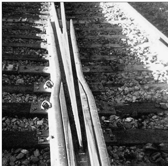
Опытная крестовина с измененными поперечным и продольным профилями поверхности катания
