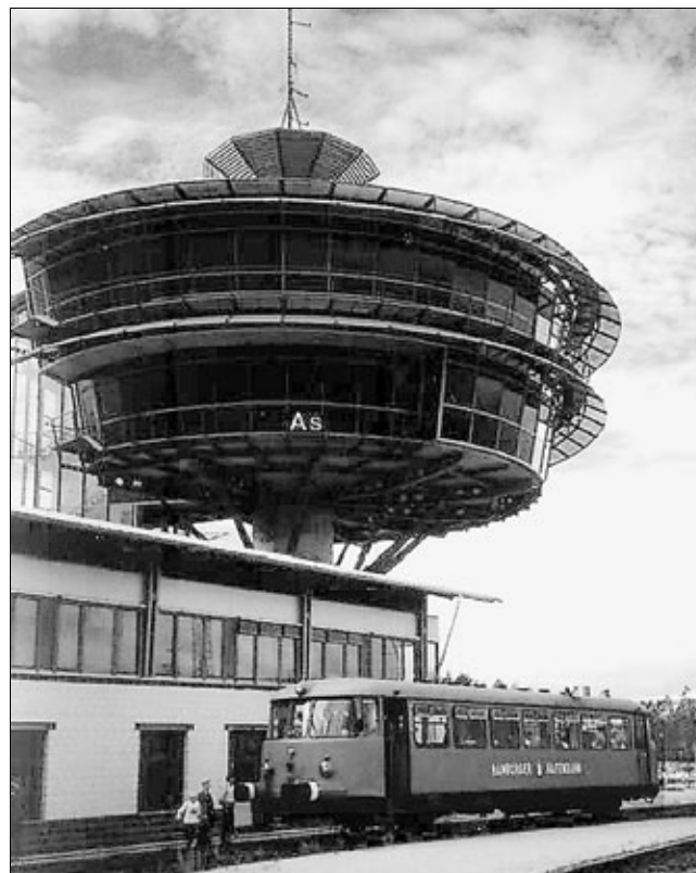
Рис. 3. Здание поста централизации на станции Альте-Зюдерэльбе
