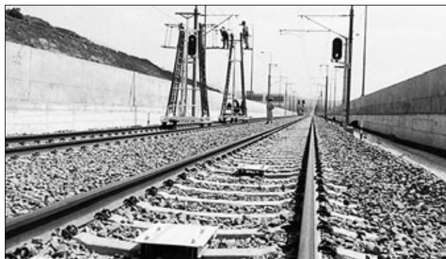
Рис. 1. Приемопередатчики системы ETCS уровня 1 компании Alstom на новой пригородной линии из аэропорта Афин в Ларису
