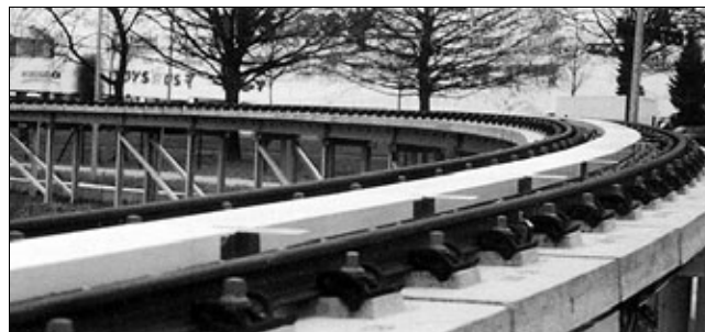
Рис. 9. Участок с длинным статором на эстакаде
