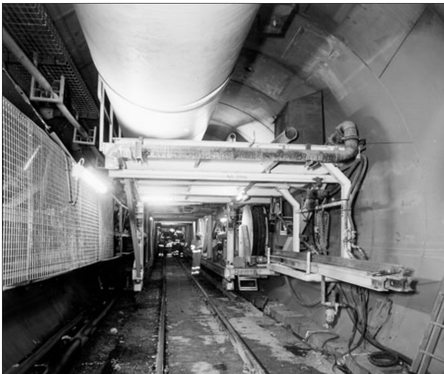
Рис. 2. Сооружение тоннеля на линии Болонья — Флоренция
