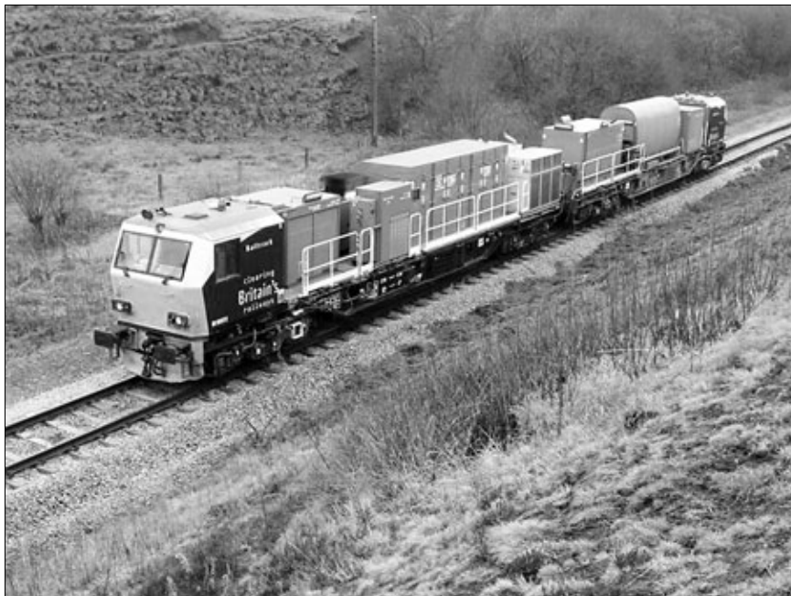
Рис. 5. Британский поезд для текущего содержания пути с установками для гидравлической и лазерной очистки рельсов
