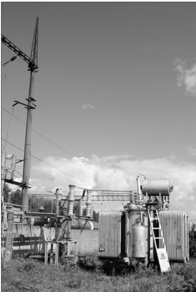
Рис. 6. Автотрансформаторный пункт системы тягового электроснабжения 2×25 кВ
