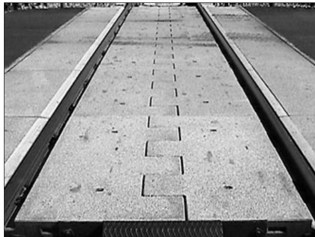
Рис. 3. Переездное покрытие Vodan компании Transpo Industries
